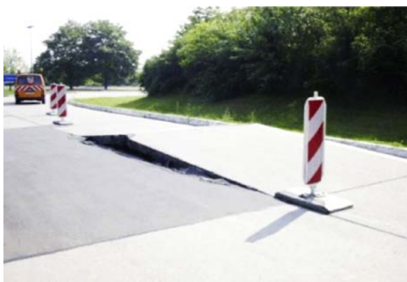
Abbildung 79: Blow Ups bei Fahrbahnplatten aus Beton. Quelle: BASt (2010).
